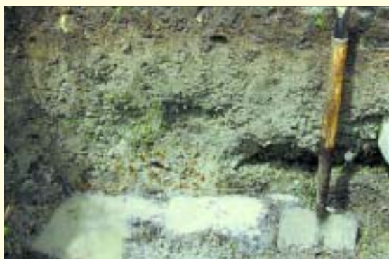
Suelo compactado con mal drenaje
